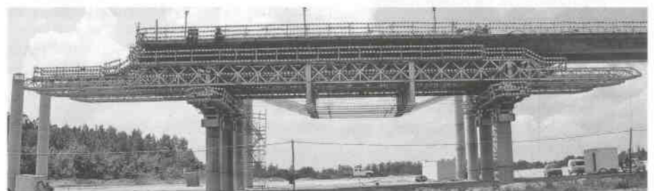
Rys. 7. Konstrukcja dźwigara przesuwnej Rio Sousa
