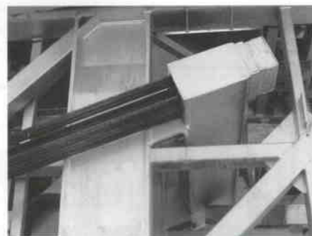
Rys. 8. Siłownik i zakotwienie (po lewej); zakotwienie bierne (po prawej)
