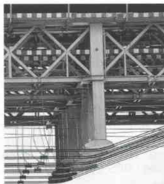
Rys. 9. Podpory dewiatorowe (po lewej); siodła dewiatorowe (po prawej)
