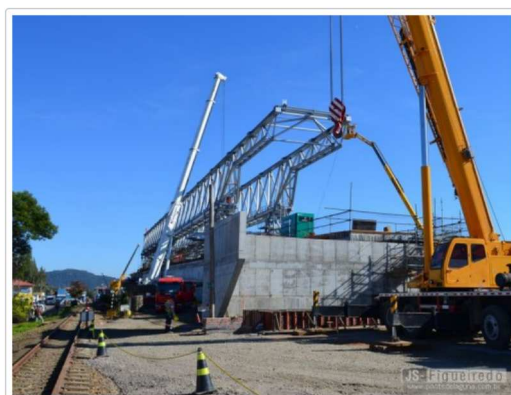
Treliza - Instalação de aduelas
