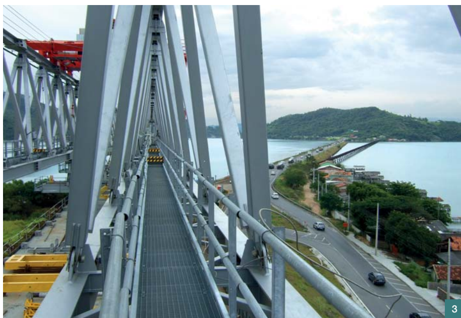
Obr. 3 Pohled ze skruže směrem k stávajícímu silničnímu náspu a železničnímu mostu ■ Fig. 3 View from the gantry, showing the existing road embankment and rail bridge
