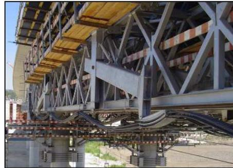
**Figura 4 – Sistema de recolha de escoras e cabos**
