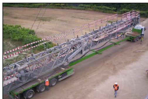
Figura 10 – Desmontagem e transporte para remontagem no 2.º tabuleiro (29/06/2005)
