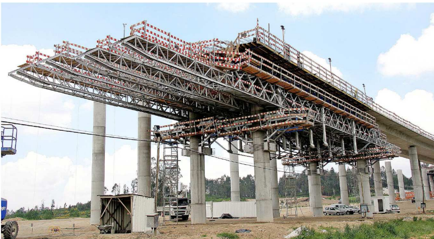
Fig. 1 Primera aplicación de una cimbra autolanzable con OPS
