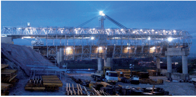
↓ Fig.3.3 M30x2-S em obra.
