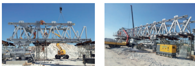
↑ Fig.5.1 Montagem do equipamento.
