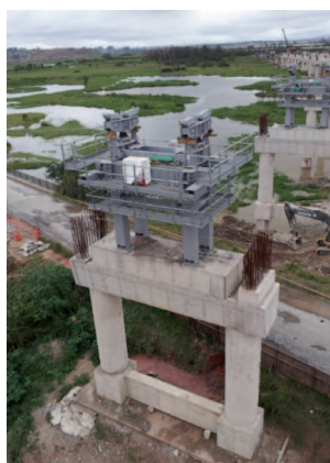
↑ Fig.3.8 Estrutura de Apoio_A.
