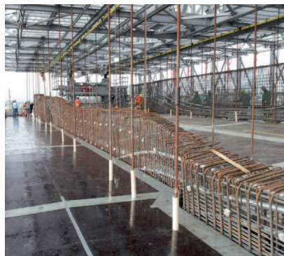
↓ Fig.5.4 Colocação das armaduras pré-fabricadas.
