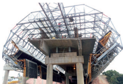
↓ Fig.5.2 Abertura das estruturas transversais.
